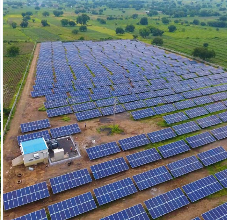
Luftaufnahme der Solaranlage Mirkala Solar
